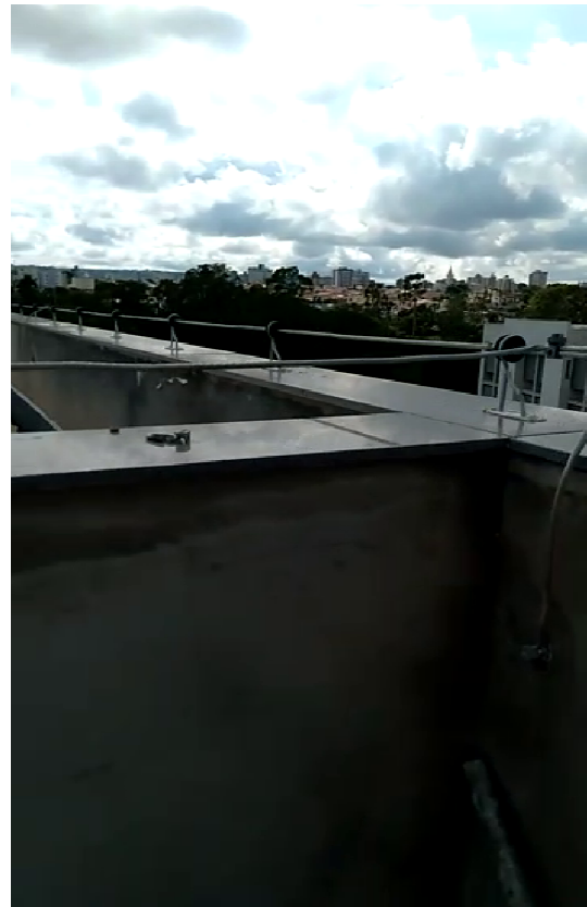
Cabo de alumínio e suporte guia na captação
